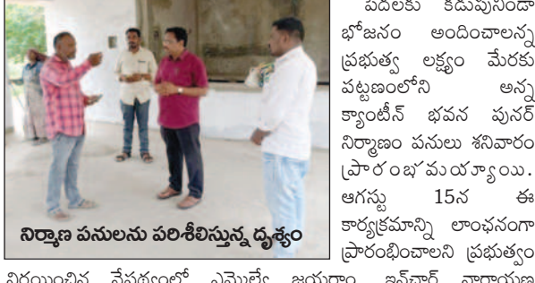
నిర్మాణ పనులను పరిశీలిస్తున్న దృశ్యం
